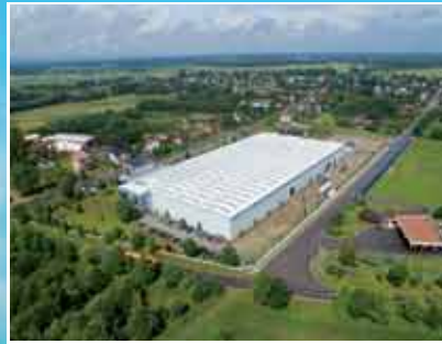
Производственный цех нет. 3 Нарев
