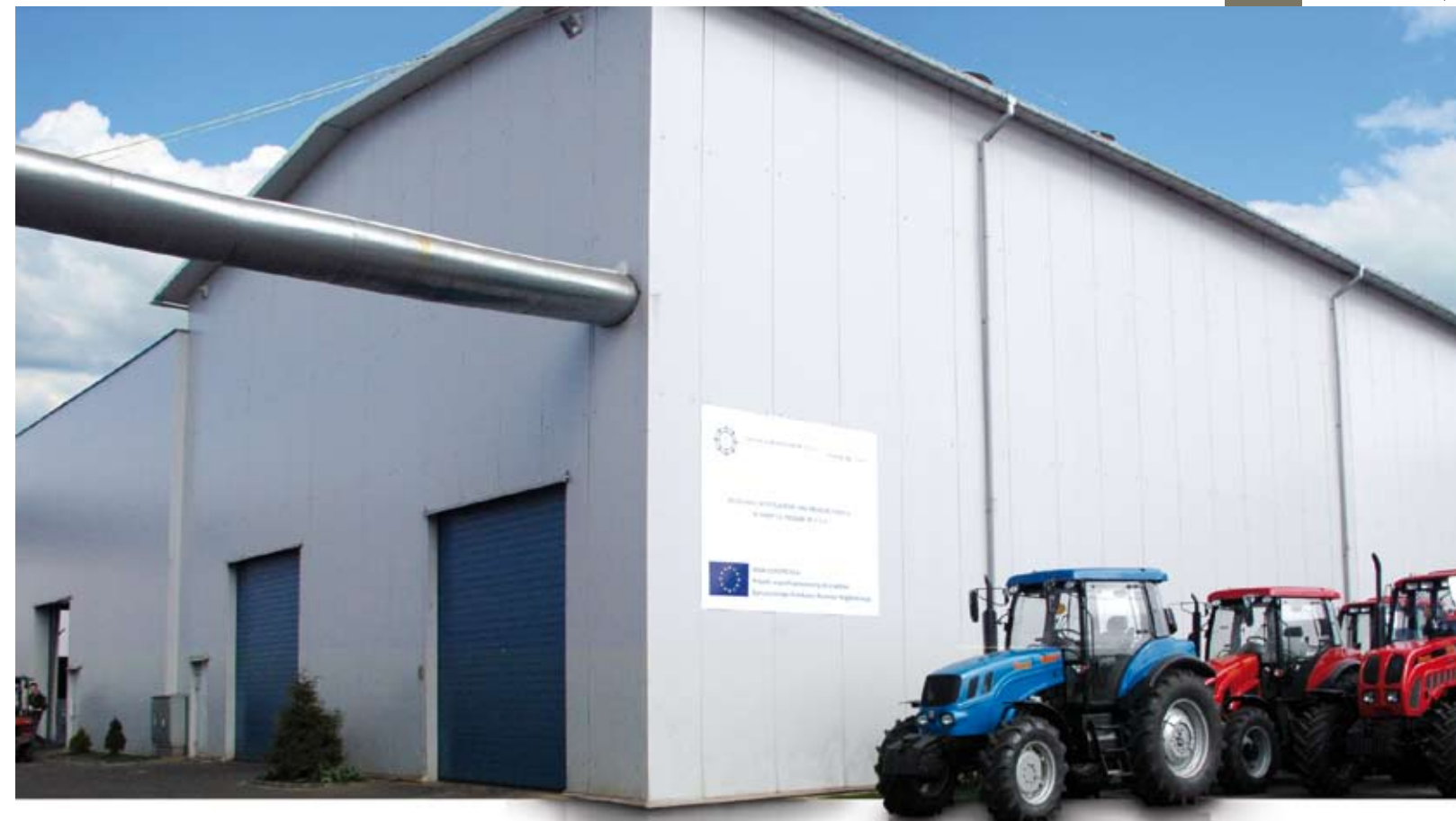
Hala produkcyjna Dzięki dotacji Pronar wybudował halę montażu ciągników i sprzętu komunalnego. Umożliwiła ona wzrost produkcji, rozszerzenie oferty asortymentowej oraz zatrudnienie ok. 200 osób
