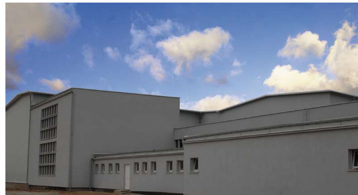
Filia Pronaru w Strabli - hale i pomieszczenia biurowe
