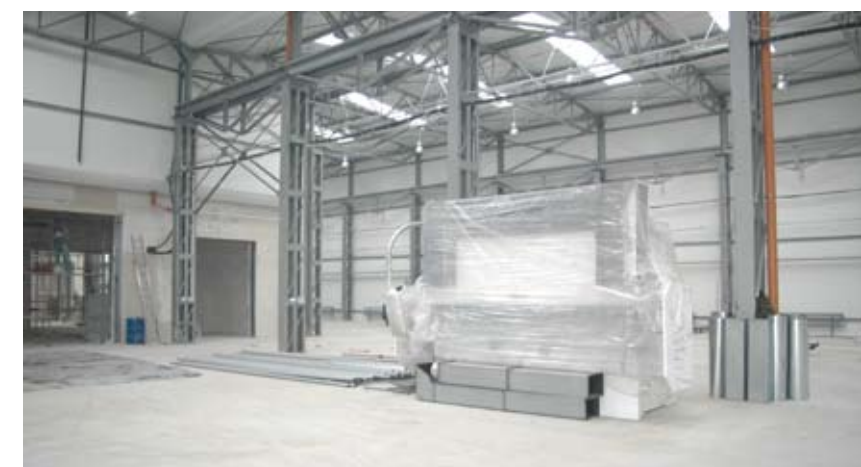
W tej hali będą wykonywane drobne elementy i zespoły wyposażenia ciągników, przyczep oraz sprzęt komunalny
