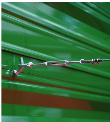
Câbles de tension en détail
