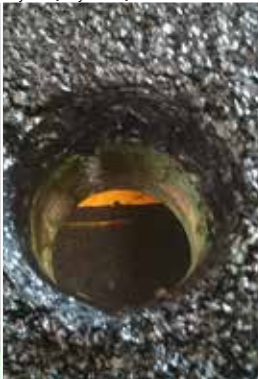
T046/1 - Podłoga z blachy ryflowanej z dwoma otworami spustowymi pokryta bezpieczną, antypoślizgową, elastyczną wylewką
