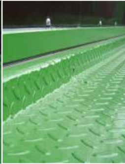
W T046/1 szczelna podłoga z blachy ryflowanej zabezpieczająca przed poślizgiem
