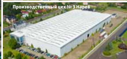
Производственный цех Наревка
