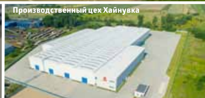
Производственный цех Хайнувка
