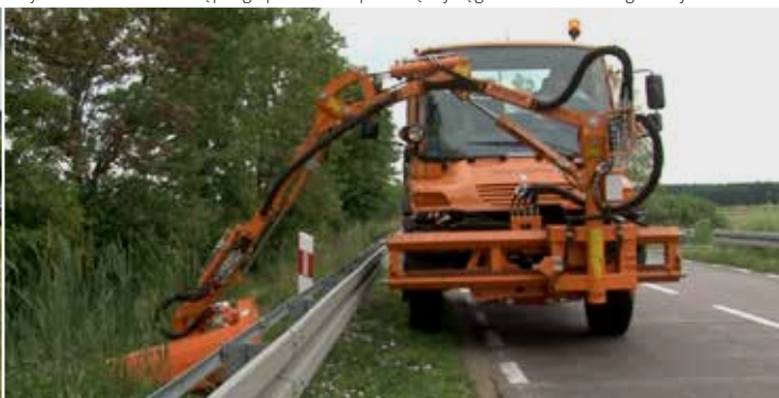
Wykaszanie trudnodostępnego pobocza za pomocą wysięgnika WWP500U i głowicy GK 110.
