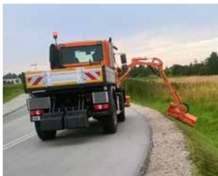
Wykaszanie trudnodostępnego pobocza za pomocą wysięgnika WWP500UH i głowicy GK 110.
