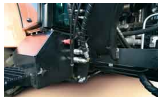
Para złączy hydraulicznych z przodu prawej strony kabiny
