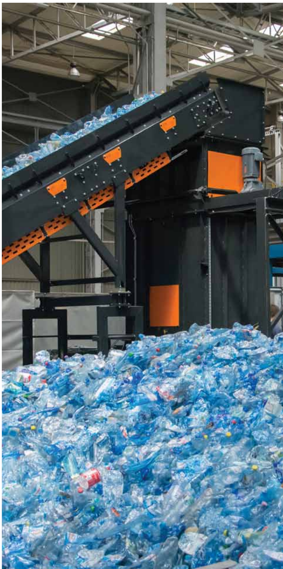
↑ Odpady typu PET poddawane są wstępnemu sprasowaniu oraz dziurawieniu przez perforator
